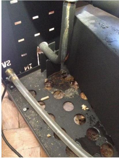
Substituição de vedantes
