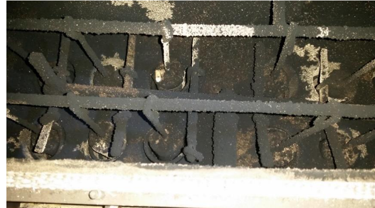
Limpeza do circuito de fumos e extrator
