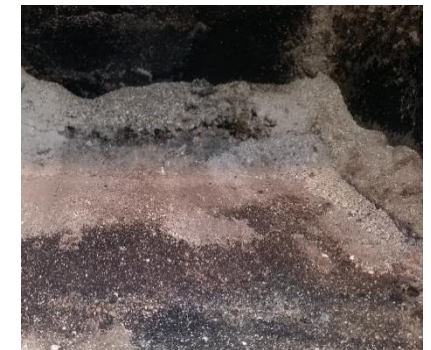
Limpeza da toma do pressostato
