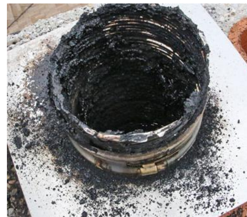
Fig. - Chaminé com Creosoto
