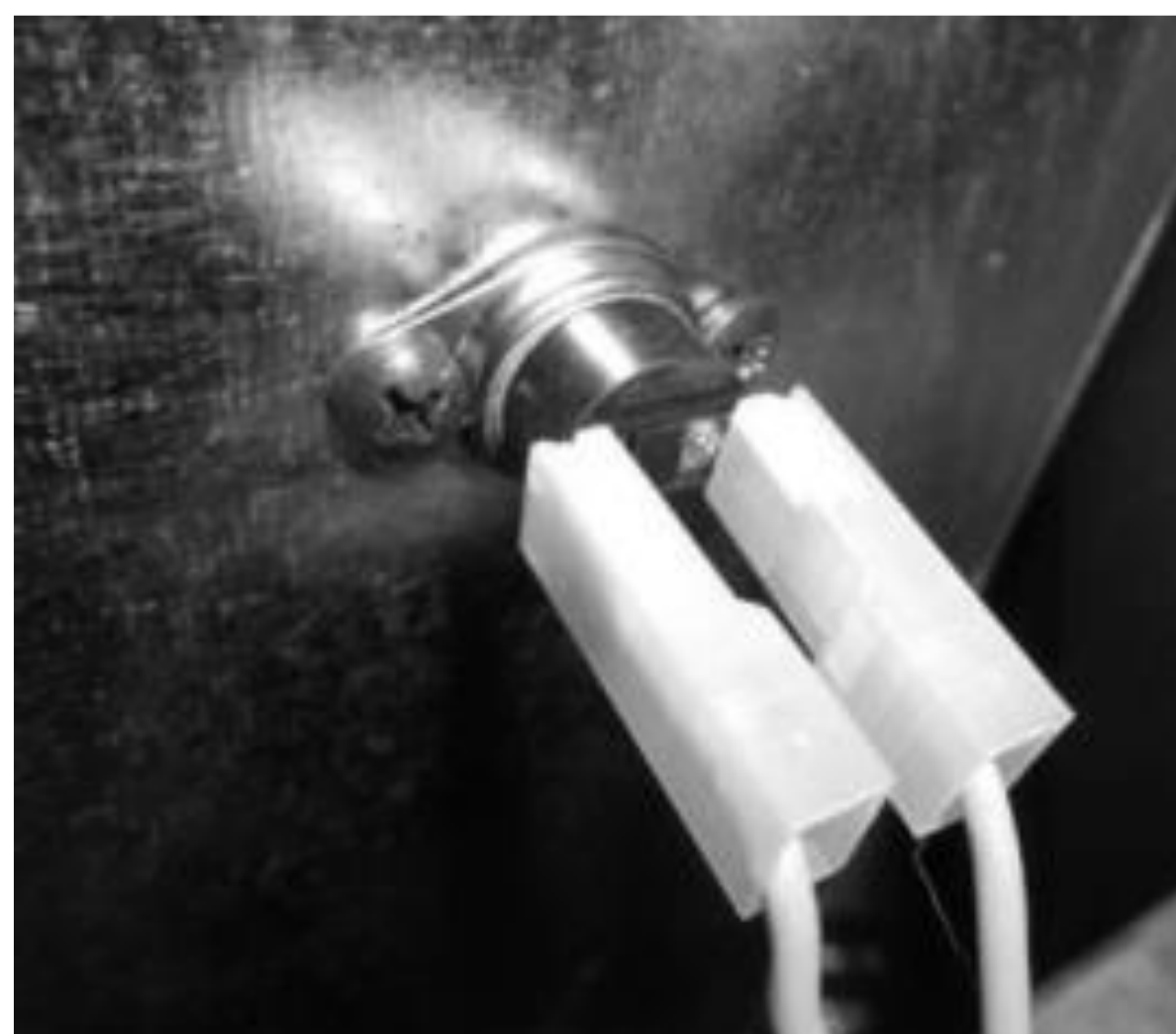
Termostato do depósito de pellets
