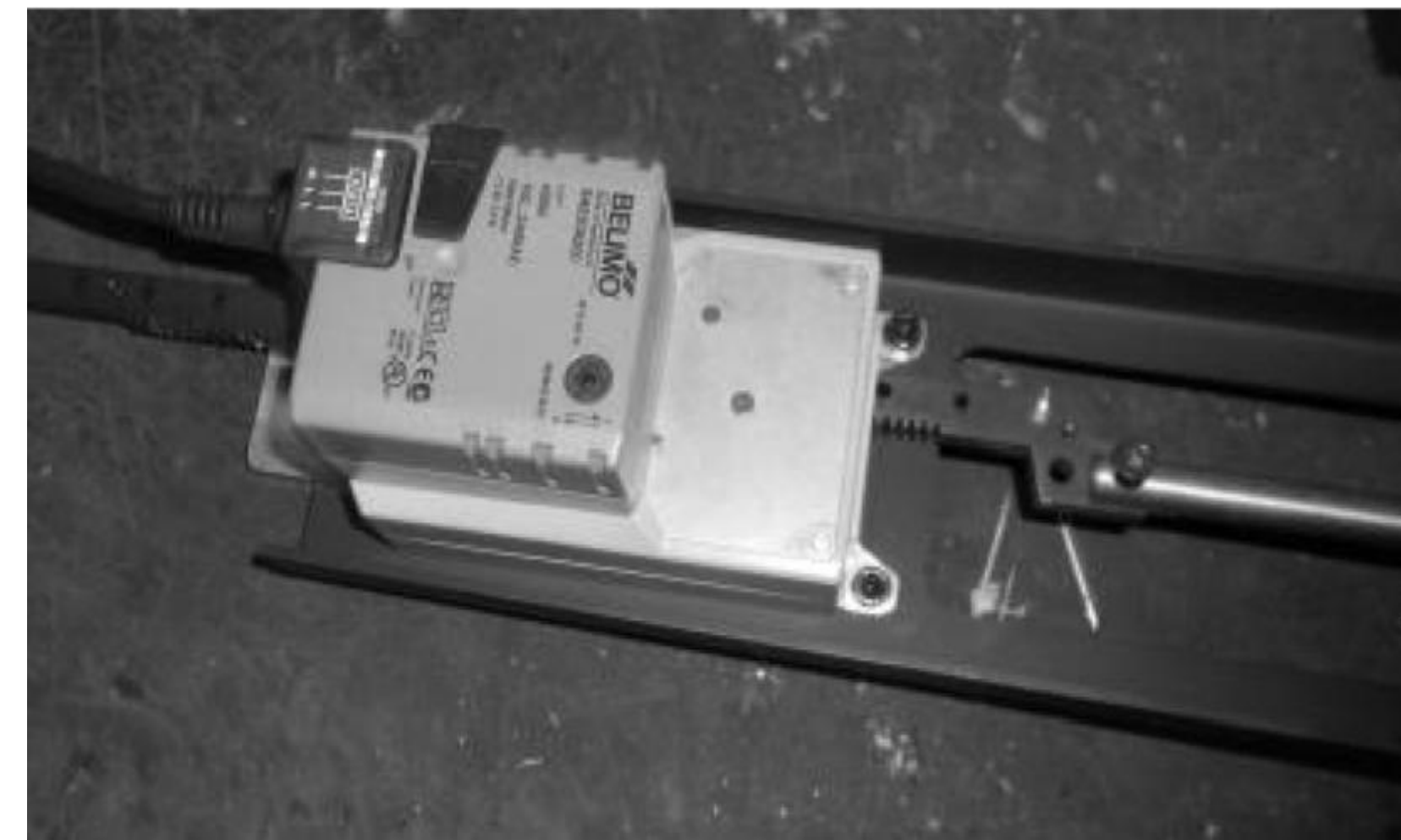
Motor linear junto à base do queimador para a limpeza das cinzas e resíduos da combustão.
